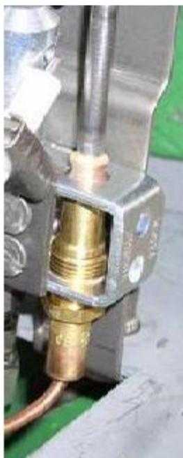
Рисунок 2.4.1.4. Внешний вид термопар запальной горелки мини-ТЭС
