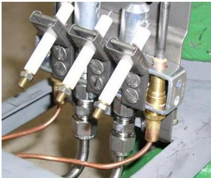
Рисунок 2.4.1.3. Внешний вид свечей системы автоматического повторного зажигания мини-ТЭС
